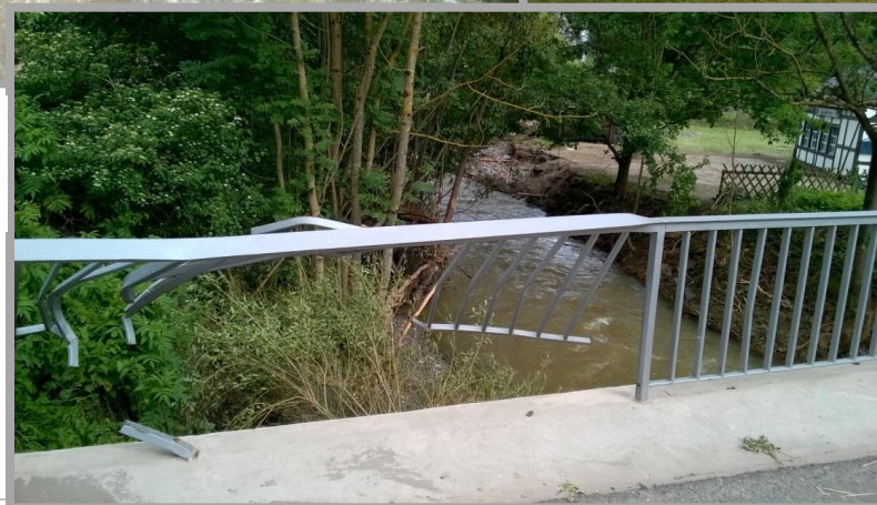
Zerstörte Brückengeländer
