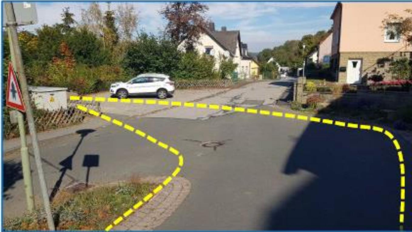
**Abbildung 13: Umbau Einmündung: Absenken im Fließbereich, Anheben in den Seitenbereichen (Quelle: Ingenieurbüro HYDRODAT)**
