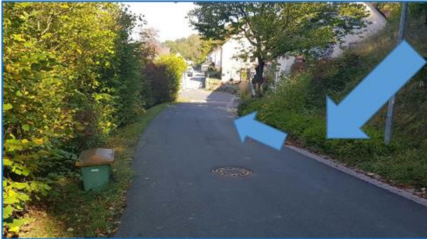
**Abbildung 4: eingeschnittener Weg mit Quergefälle (Ingenieurbüro HYDRODAT)**
