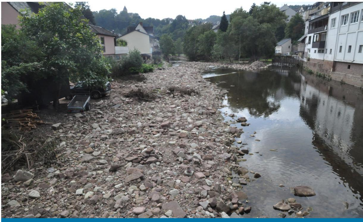
Abbildung 3: Kyll bei Kyllburg: massive Geröllablagerungen (Geschiebe) im Brückenbereich sind zu beseitigen (2021)
