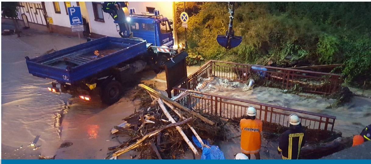
Abbildung 2: Einsatzkräfte entfernen Verkläuser vor Verrohrung in Wellmich (VG Loreley)
